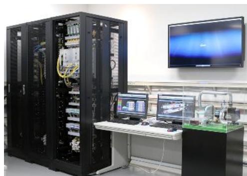
ビルプラント1
